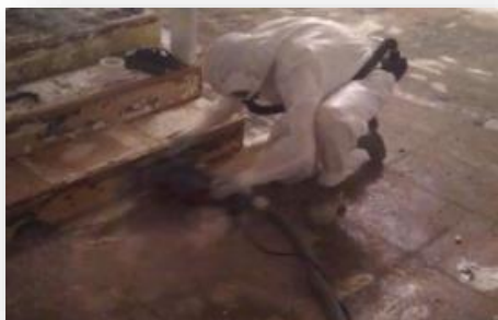
Opération de « bordurage » avec meuleuse Hilti
