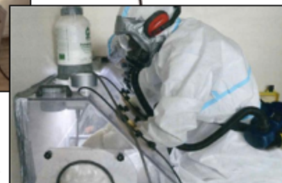
Dépose de sols amiantés
